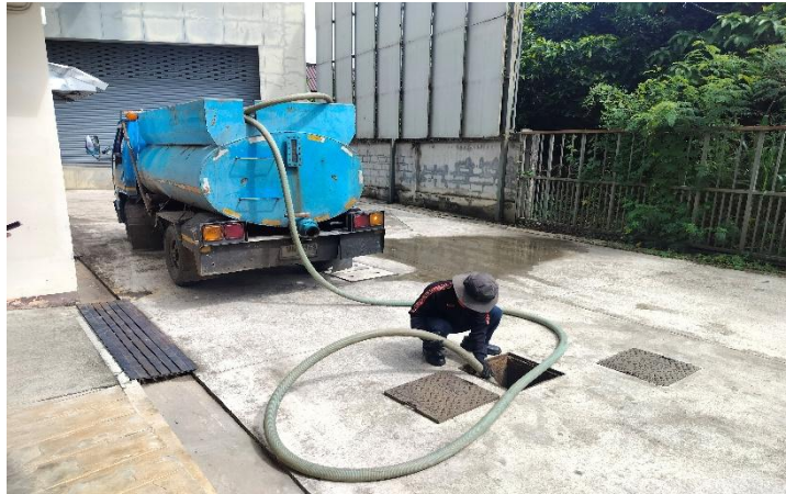
รูปที่ 2-10 รูปการณ์สูบน้ำออกจากบ่อดักไขมัน
